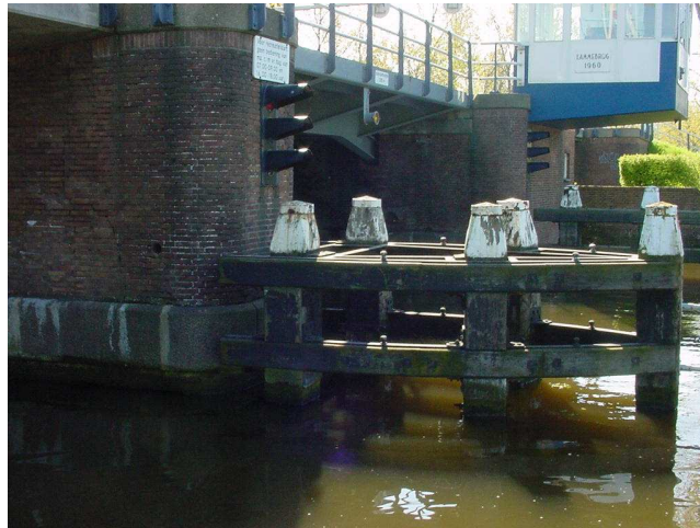
Figuur 5, de bovenste foto geeft de verbrede noordzijde aan, het dek kraagt uit over de pijler. De onderste foto geeft de niet verbrede zuidelijke zijde weer.
