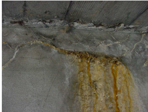
Figuur 3, detail opname oplegbalk in pijler
