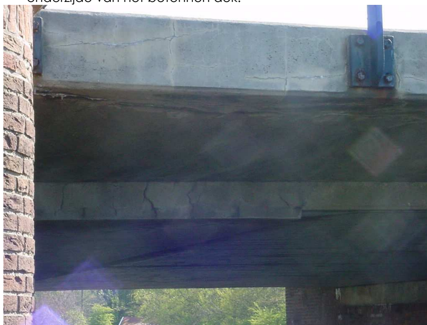
Figuur 1, herstelwerk van de onderrand van de aanbrug. Divers scheurenpatroon
